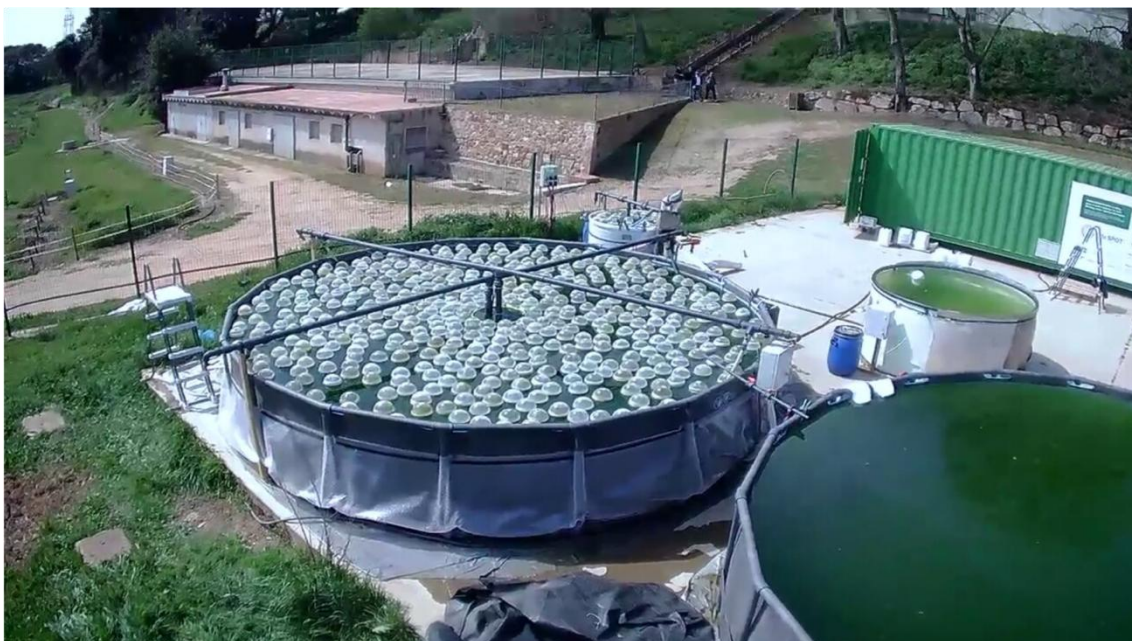
Planta piloto Life SPOT en las instalaciones de Torre Marimón, Caldes de Montbui
